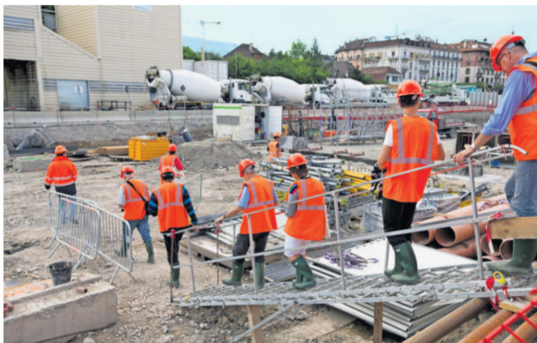
Le manque d'ingénieurs se fait particulièrement sentir dans le domaine de la construction. KEYSTONE
